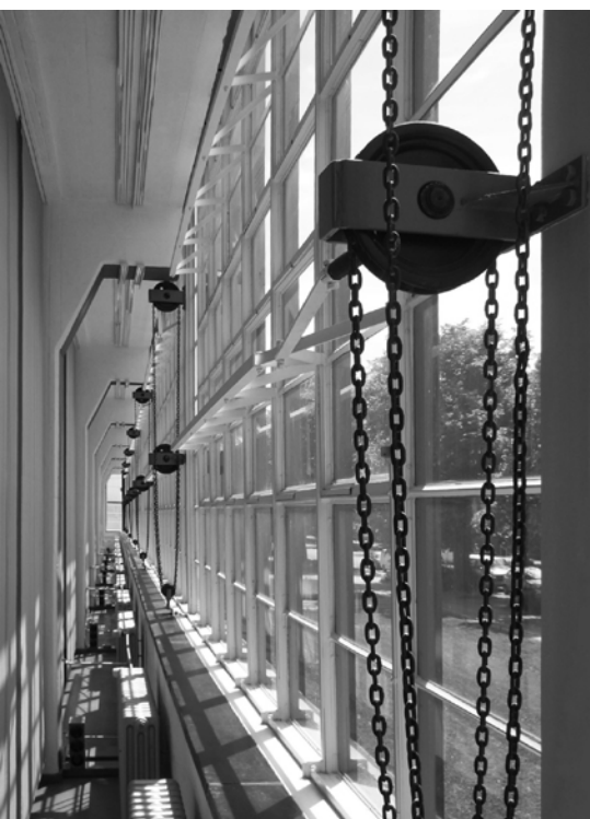
Szárnyak nyitására alkalmazott távnyitó szerkezete gépészeti tere, Dessau (1926)
